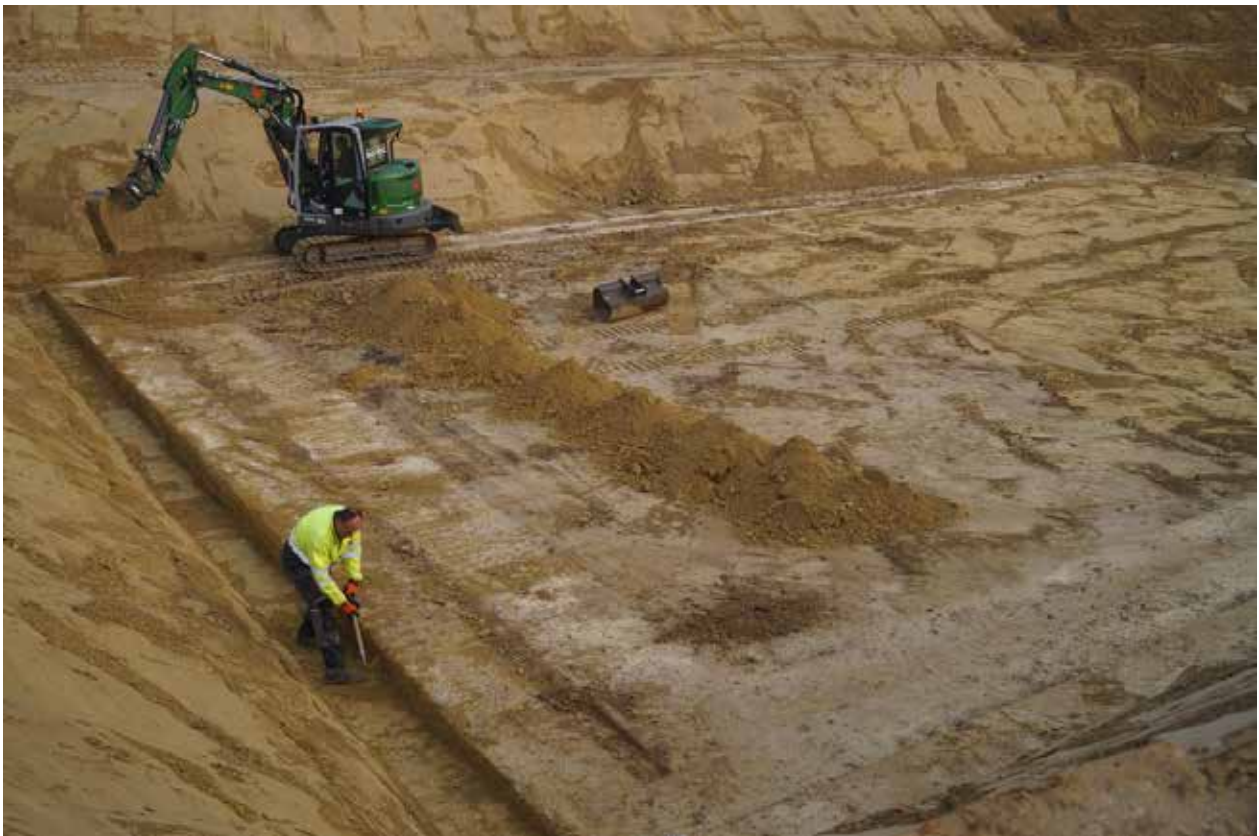
Ebelsberg, NS-Zeitliche Baugrube mit Fundamenten eines Tiefkellers / Ebelsberg, Nazi-period excavation pit with foundations of a sub-cellar (© ARCHEONOVA, Wolfgang Klimesch).
