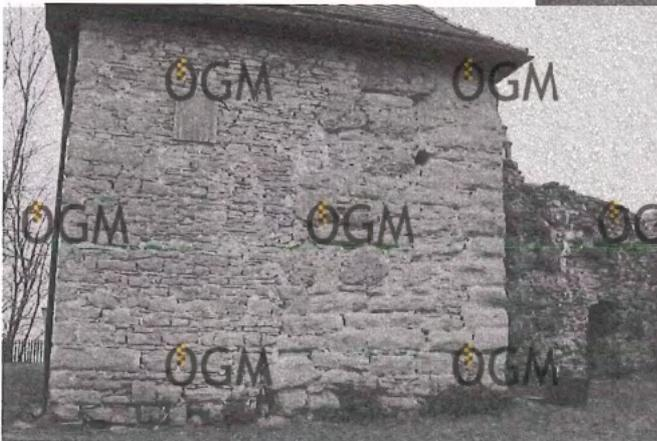
**Abb. 11:** Burg Hohen Bregenz bei Bregenz. Brunnenturm-Nordseite. Verschiedenes Mauerwerk, 13. und 18. Jahrhundert, erkennbar. (Photo: R. RHOMBERG 2004).
