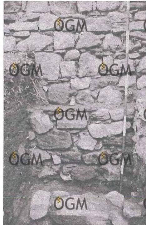
**Abb. 19:** Hainburg, Wasserturm. Fundament und Aufgehendes der Stadtmauer in Sondage 1. (Foto: Nikolaus HOFER, AS).
