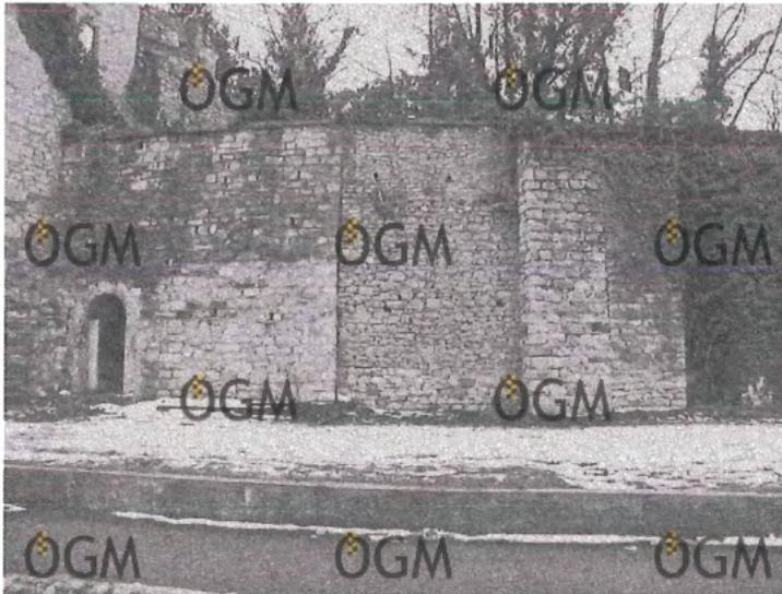
**Abb. 18:** Hainburg. Stadtmauerabschnitt westlich des Wasserturms mit sekundären Strebepfeilern und Ausbesserungen. (Foto: Nikolaus HOFER, AS).
